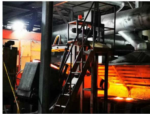
Automatic Pouring Line 自动浇注线
